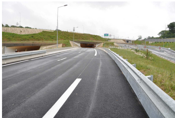
A86 Pont Colbert : Accès et sortie poste de péage
