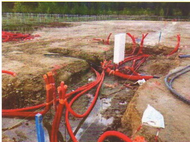
5. Tranchées pour installer le câblage électrique dans le sol classé du terrain des Mortemets
