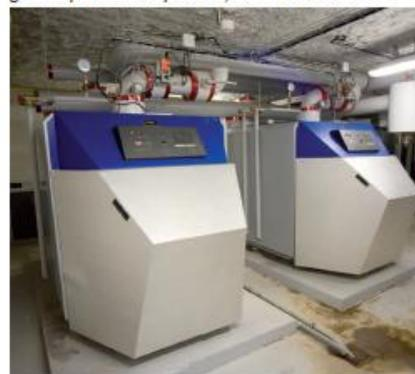
Deux chaudières gaz à condensation et à brûleur modulant Atlantic Guillot de 980 kW produisent la chaleur pour la mise en température des bassins et l'alimentation de la pompe à chaleur à cycle à absorption.
