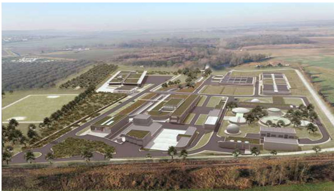
L'usine de dépollution de Carré de Réunion
