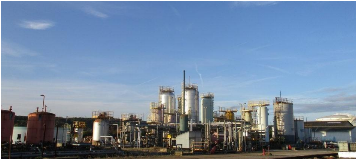
Les panneaux solaires vont être installés sur l'espace occupé auparavant par la raffinerie. (©Le Courrier de Mantes)
