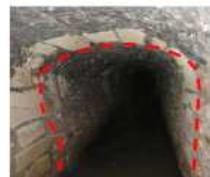
Vue de la déformation de l'ouvrage et de bombement du piedroit gauche à proximité de R25 et de R26
