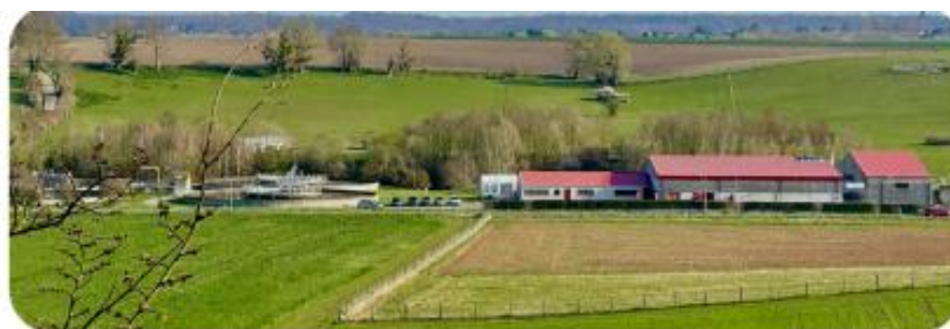
L'usine d'épuration Val de Gally - en site classé de la Plaine de Versailles
